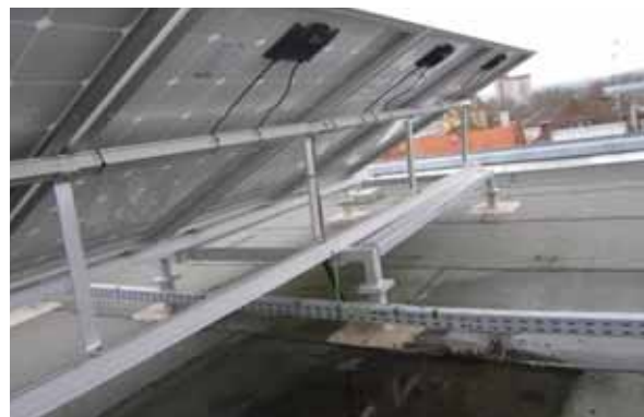
Bild 15: fachgerechte Leitungsverlegung (Quelle VGH)
